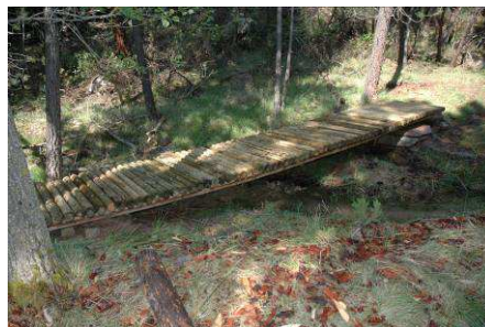
Pasarela en Barranco el Regajo
