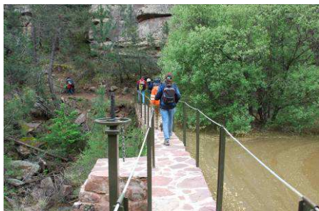
Dique de retención de agua para las minas de Bezas
