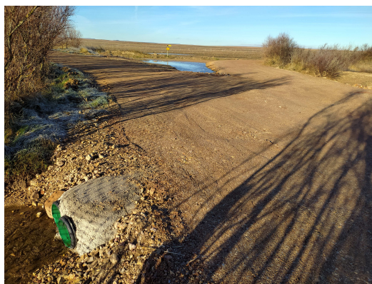
Drenaje con 2 tubos y elevación de la pista en Aguanares Limpieza de la cuneta y elevación pista Aguanares
