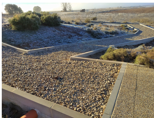
Conexión del aparcamiento con pasarela de Gallocanta Conexión con bordillo de hormigón y firme de grava
