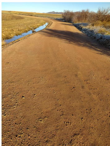
Drenaje con 2 tubos y elevación de la pista en Aguanares Limpieza de la cuneta y elevación pista Aguanares
