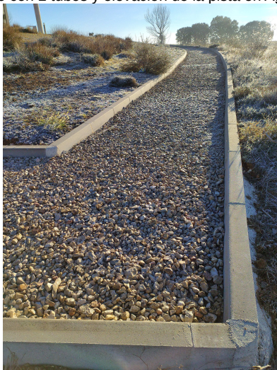
Conexión del aparcamiento con pasarela de Gallocanta Conexión con bordillo de hormigón y firme de grava
