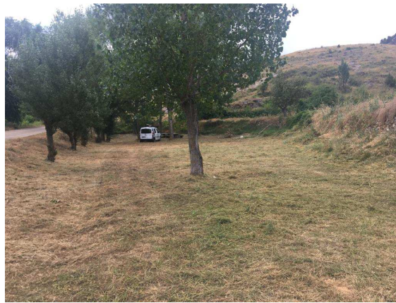
Desbroce del área recreativa de Molinos.
