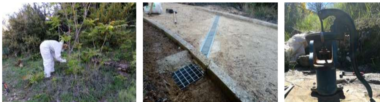
Ilustración 2 Tratamiento aiantos Rodellar, Desagüe en S-1 e Instalación de Fuente Otín
