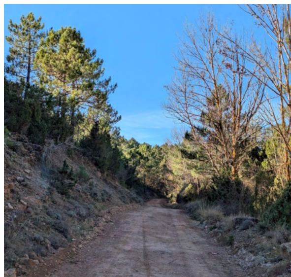
Firmes en pista de Hoyos Quemados.
