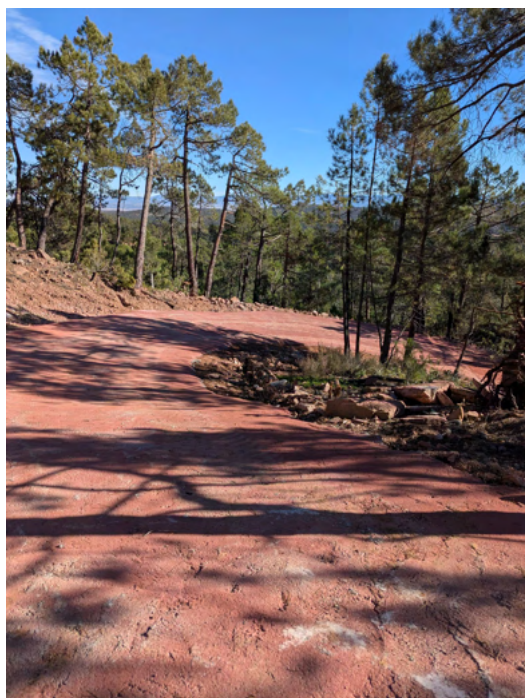
Hormigado en subida en pista Peña del Hierro.
