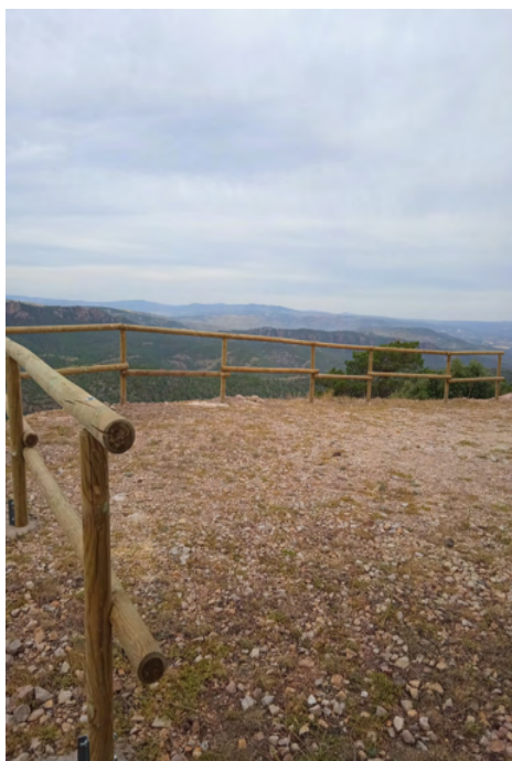
Adecuación de vallado en Sierra Carbonera.
