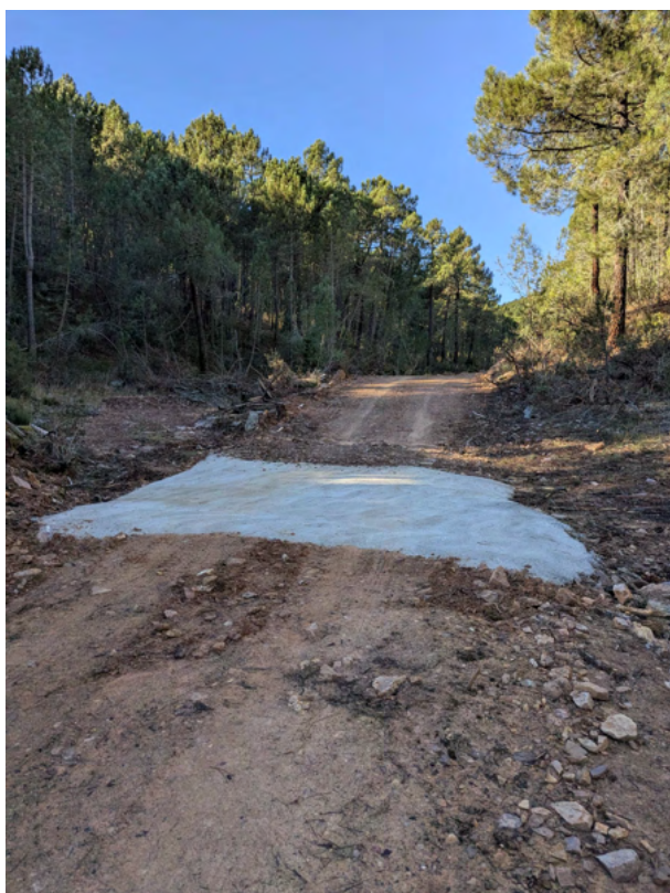
Mejora del firme y cunetas, y badén de hormigón en barranco de Las Clochas.
