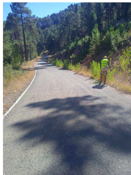
Desbroce de cuneta en la pista forestal asfaltada Dornaque-Albarracín.
